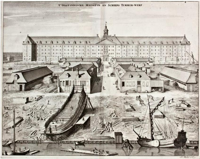
Fig. 9. Chantier naval de la VOC sur l'île d'Oostenburg à Amsterdam avec, à l'arrière-plan, le grand entrepôt – *East Indian Sea Warehouse* –, et au premier plan la cale de lancement. Gravure de Mulder, 1694
