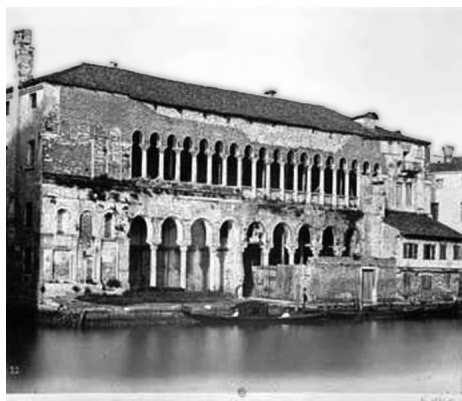
Fig. 2. Le Fondaco dei Turchi avant rénovation à la fin des années 1850, photographie de Carlo Naya (1816-1882) (source : Wikimedia commons)
