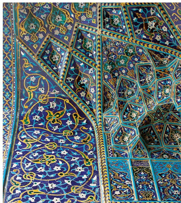
33. Ispahan, Darb-i Imâm, décor ornant la demi-voûte du pîshâtâq (2009)
