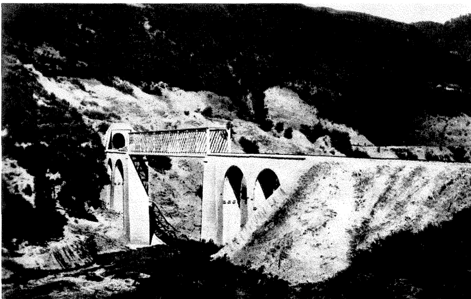
Pont de 4 voûtes en maçonnerie de 10 m et d'un tablier de 50 m au Km 331 65
