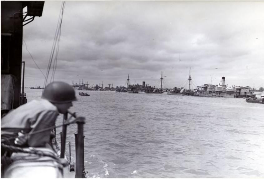
Fig. 10. Éléments de la structure du port artificiel constitués par une ligne de bateaux coulés (Gooseberry). Fonds NARA – Cliché 80-G-285153
