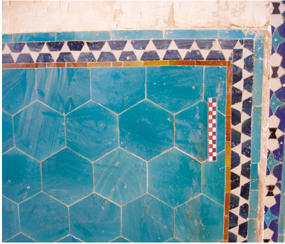
9. Bunderâbâd, complexe Taqî al-dîn Dâdâ à Bunderâbâd, détail du lambris de la mosquée : restaurations modernes (2009)
