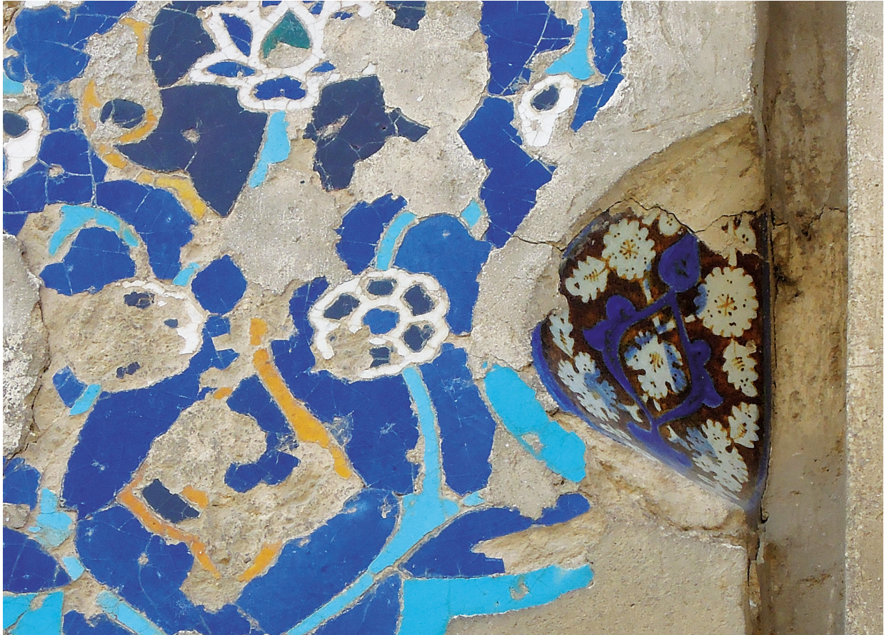
24. Tabriz, Mosquée bleue, sections de carreaux à décor de lustre métallique sur glaçure mises en place sur les bases des colonnettes du mur-écran du pishṭâq (2014)
