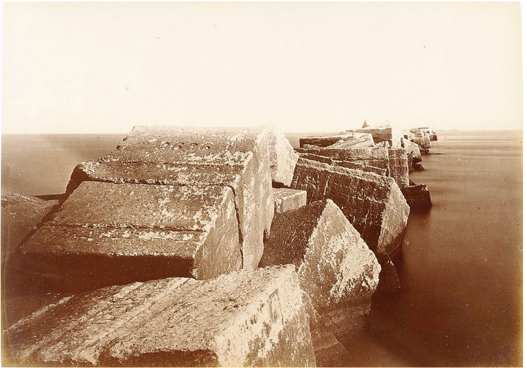
3. Blocs artificiels à Port-Saïd (BnF, VF-560-PET FOL, album de Justin Kozłowski, 1869)
