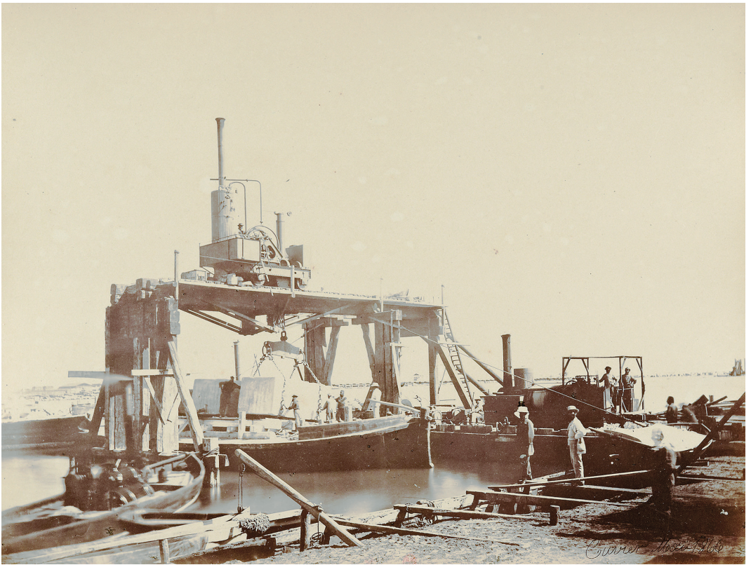
2. L'embarquement des blocs avant immersion à Port-Saïd (BnF, VH-265-PET FOL, album de Louis Cuvier, 1867)
