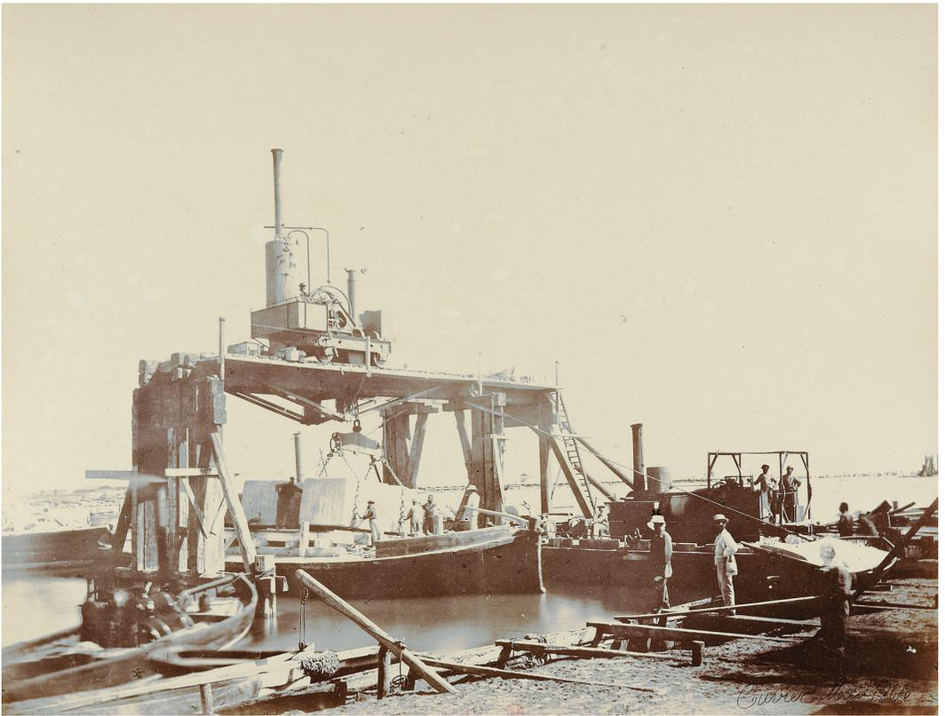
2. L'embarquement des blocs avant immersion à Port-Saïd
