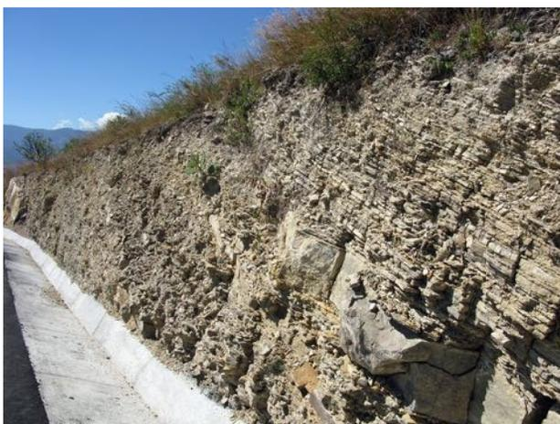
Fig. 502. Le percement de la route touristique reliant la route Ignacio Bernal au site d'Atzompa a recoupé les niveaux marneux et les bancs calcaires de la Formation Jaltepetongo
