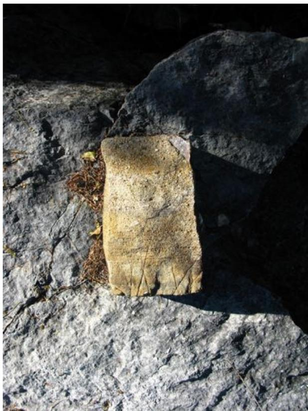
Fig. 488. Détail du moellon d'arkose posé sur la masse calcaire de gauche. Outre sa forme et l'importante érosion de sa face supérieure par les intempéries, il a été apporté depuis un autre lieu
