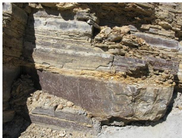
Fig. 503. Détail des niveaux recoupés par le percement de la nouvelle route touristique. On observe entre les bancs calcaires des lits de marnes jaunâtres
