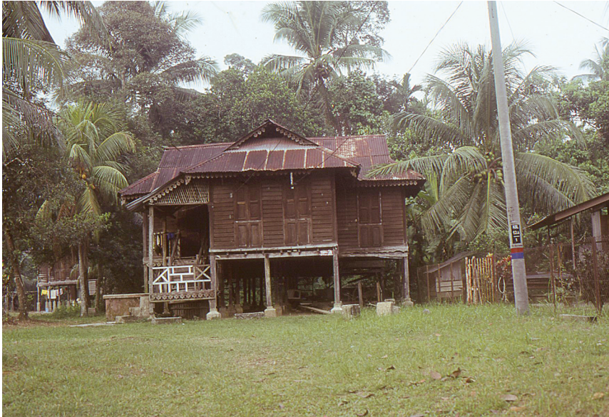
3. Maison malaise à Saiong près de Kuala Kangsar, Perak, Malaisie péninsulaire La maison est « posée », les hauts pilotis reposant sur des parpaings. Hormis la toiture, qui autrefois était en bardeaux, la construction est totalement en bois. On distingue nettement la véranda et le fronton triangulaire ouvragé.
