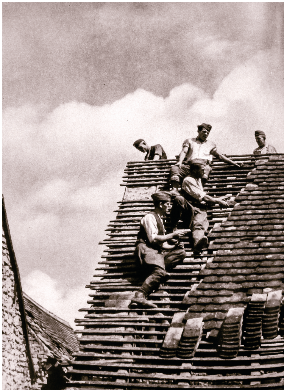
18. Travaux de réparation dans un village de la « zone rouge » allemande.
