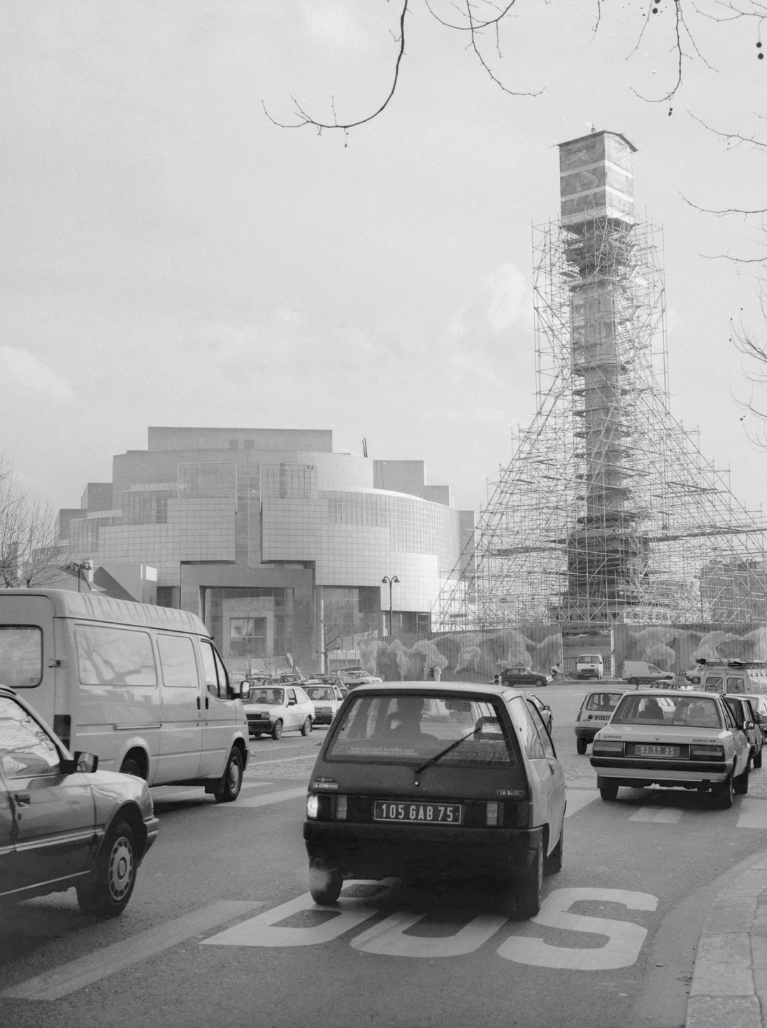
16. La colonne de Juillet, place de la Bastille, en cours de restauration, et l'opéra Bastille, Paris, février 1989
