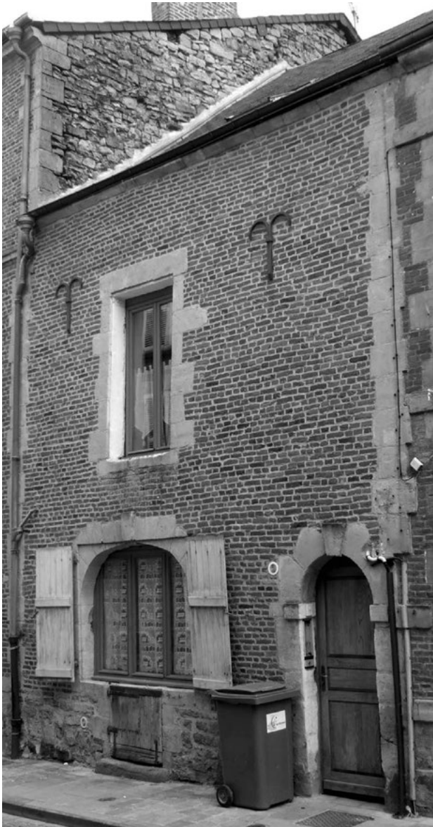
7. Aménagement spécifique pour une boutique, avec baie cintrée et porte coupée flanquée de murets à hauteur d'appui, rue aux Juifs (auj. rue Hippolyte Taine) à Charleville (état en 2009) (cliché Youri Carbonnier)
