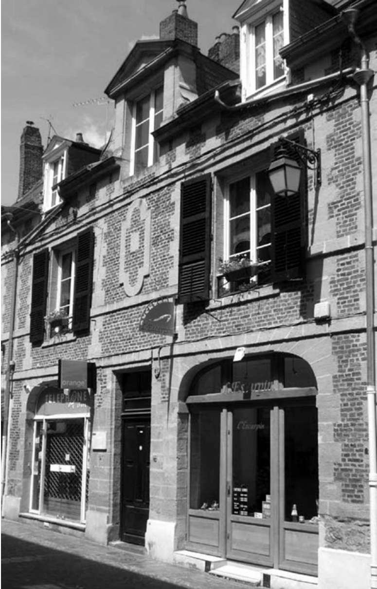
6. Maison de la rue Saint-François (auj. rue de la Paix) à Charleville (début xvii e siècle), montrant l'aménagement d'une porte d'accès aux étages, indépendante des deux boutiques inscrites dans une baie à arcade (état en 2009) (cliché Yuri Carbonnier)
