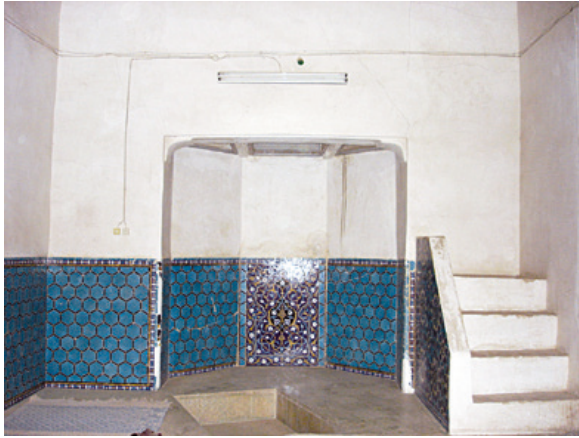
147. Yazd, Mosquée Amîr Khîzrshâh, vue d'ensemble du mur qibla (2006)
