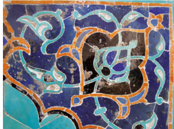
12. Yazd, Masjid-i Sar-i Rîg, détail du mihrab en mosaïque de carreaux découpés avec rehauts d'or (2014)
