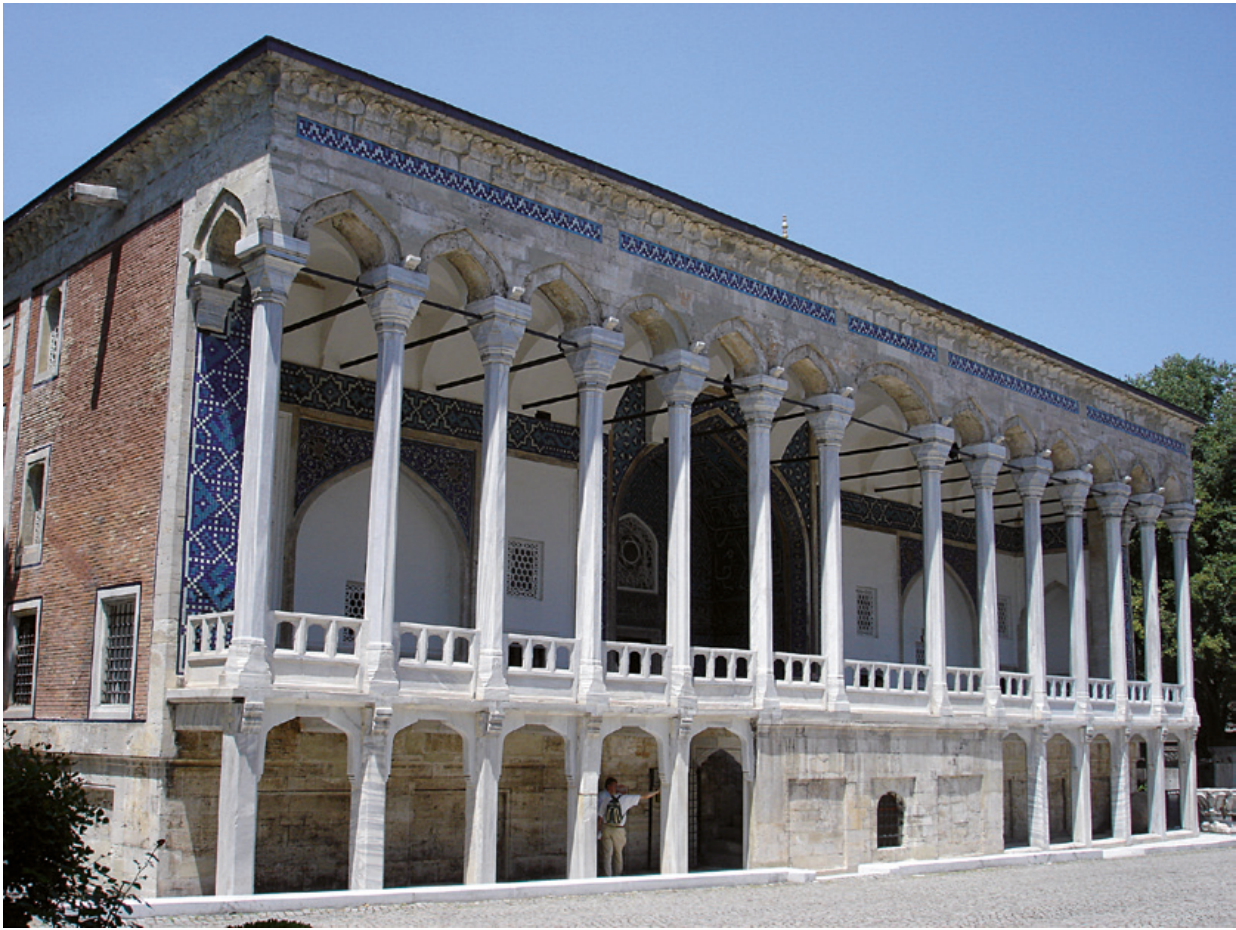
275. Istanbul, Çinili Köşk (palais de Topkapı), façade principale du monument (2006)
