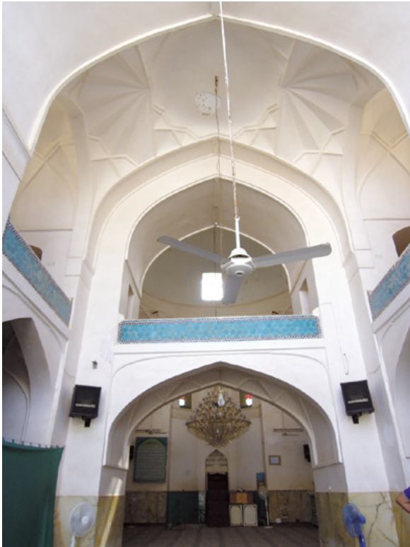
210. Âbrândâbâd, Masjed-i Jâmi', iwan ouvrant sur la salle de prière à coupole (2014)
