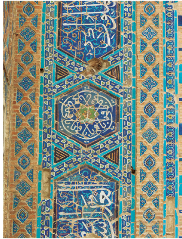
89. Shahr-i Sabz, palais Âq Sarây, détail du décor en céramique à « ligne noire » sur fond de briques non glaçurées (2013)
