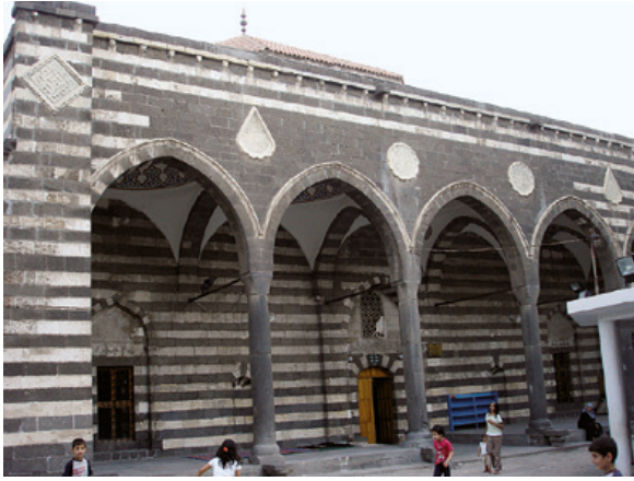
238. Diyarbakir, Safa Cami, entrée de la mosquée (2006)
