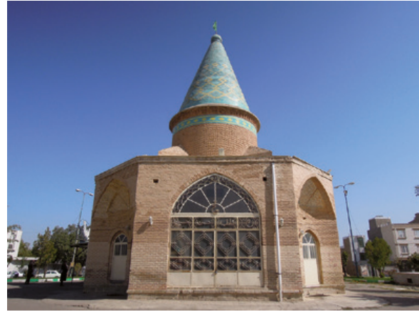
61. Abhar, mausolée de Shâhzâda Zayd al-Kabîr, vue extérieure (2014)
