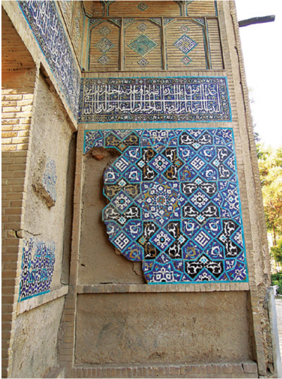
122. Ispahan, Darb-i Kûshk, parois latérales du pîshâtâq (2014)
