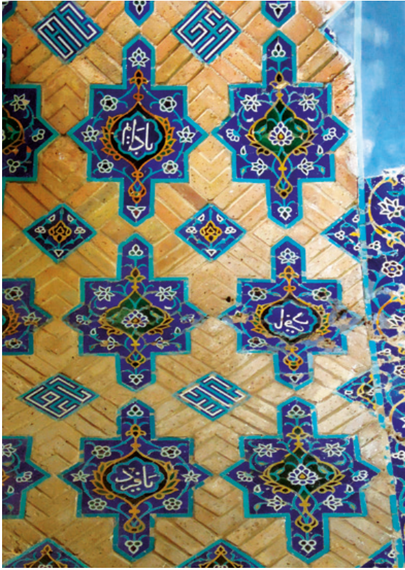
8. Tabriz, Mosquée bleue, détail du décor de l'intrados des arcs hauts dans la salle à coupole centrale : au registre intermédiaire, noter la calligraphie découpée à l'envers (2014)
