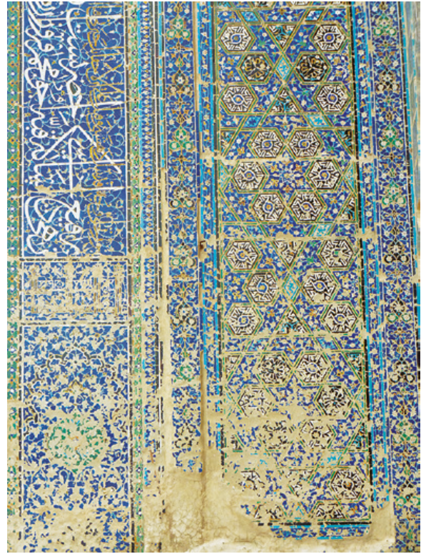
91. Shahr-i Sabz, palais Āq Sarây, décor en mosaïque de carreaux découpés du pîshîâq (2013)
