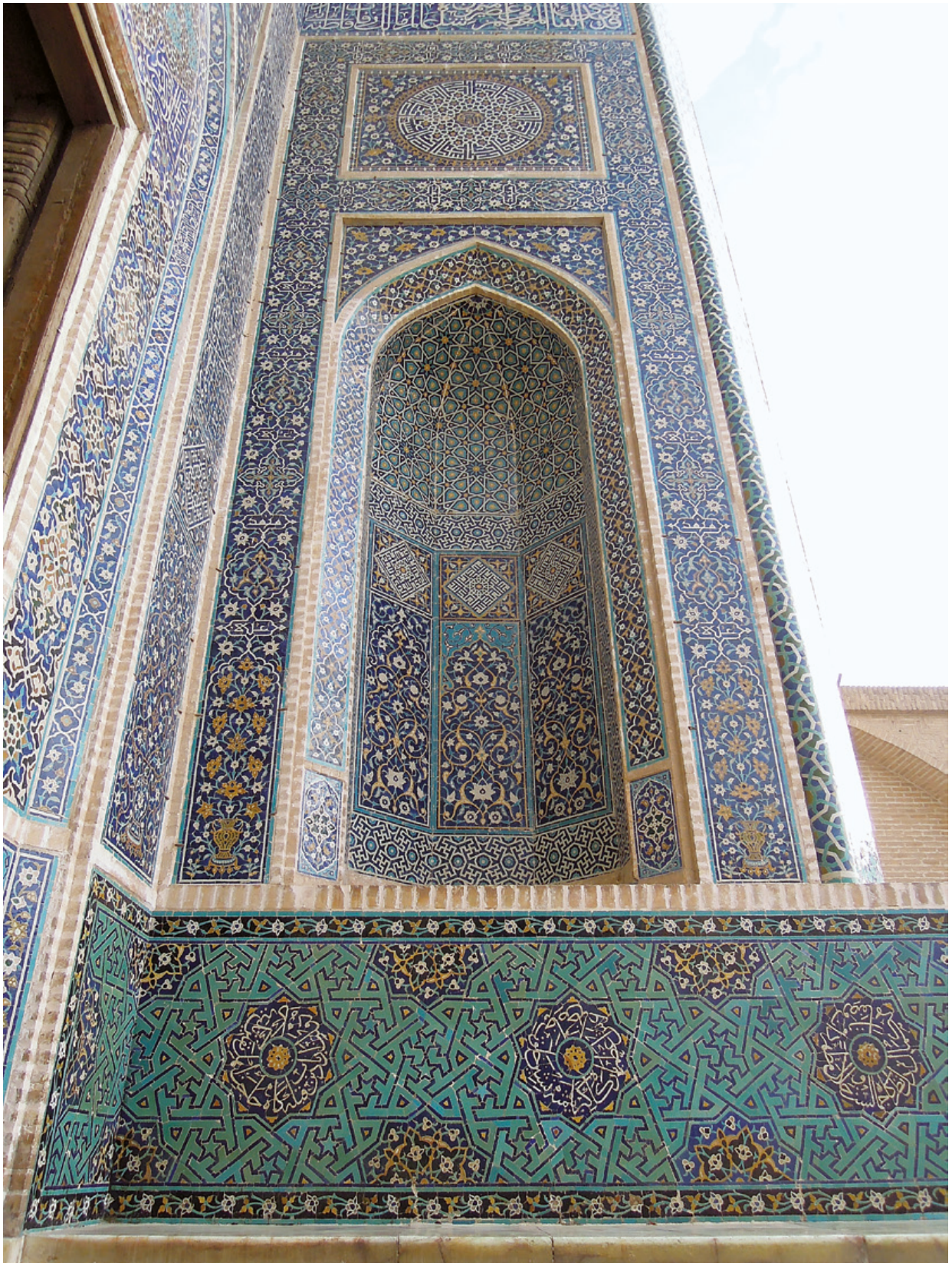
164. Yazd, Masjid-i Jâmi', vue sur la partie inférieure du pishṭâq : le mur-écran et les panneaux encadrant directement la porte sont des restaurations modernes (2014)
