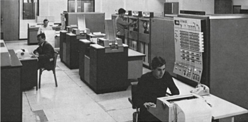
Figure 25. Centre scientifique IBM-IMAG : l'ordinateur IBM/360-67, dont l'architecture avancée offre à la fois un moyen de calcul puissant et un sujet de recherches (1969)
